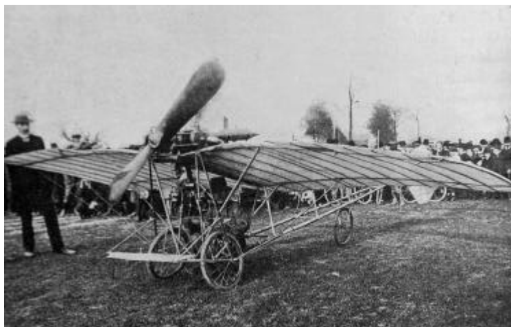
Une Demoiselle n° 20 à moteur Dutheil et Chalmers refroidi par air, 1909.
