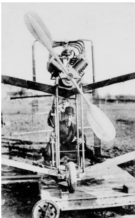
Le n° 15 à Saint-Cyr le 7 mars 1907. Santos-Dumont doit tenir dans la main droite la commande d'allumage du moteur, ce qui provoqua le crash.
