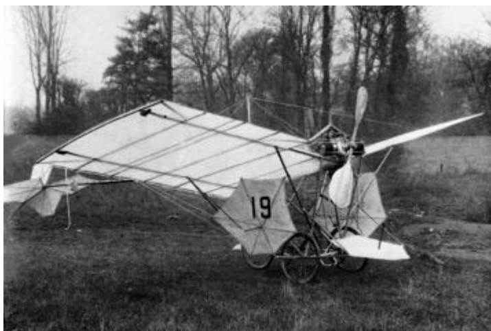
Le n° 19 tel que présenté à Neuilly le 16 novembre 1907, avec ses plans latéraux et avant et son flat-twin Dutheil et Chalmers.
